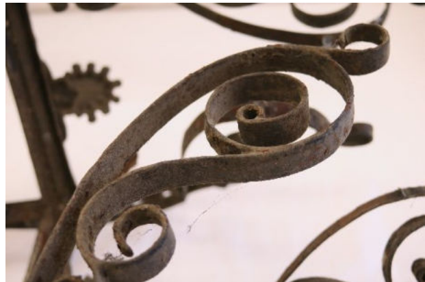
2. ábra Szennyeződés és vaskorróziós termékek a tárgyon
