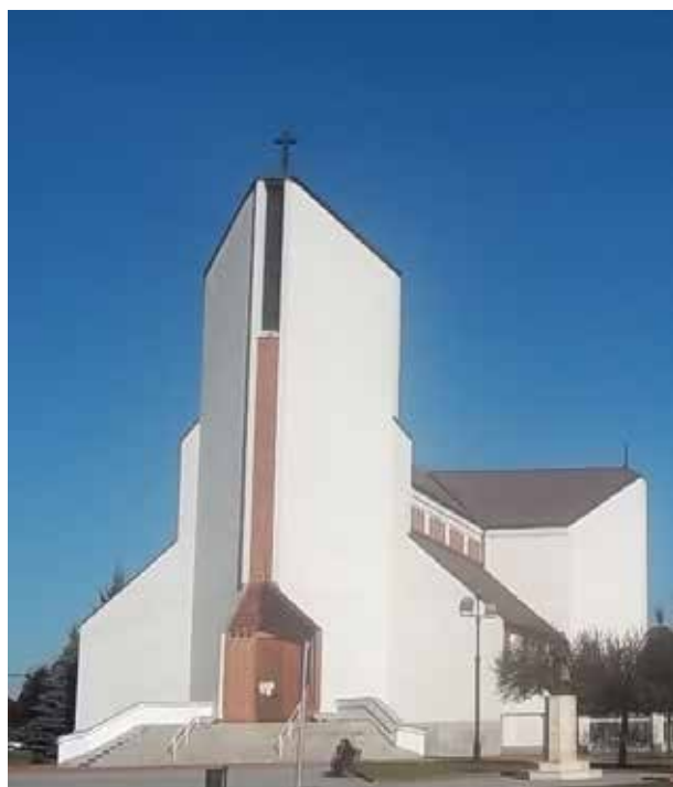
7. kép. A tiszaiúvárosi római katolikus templom délnyugati homlokzata a főbejáráttal. (Fotó: Vámosi Katalin)
