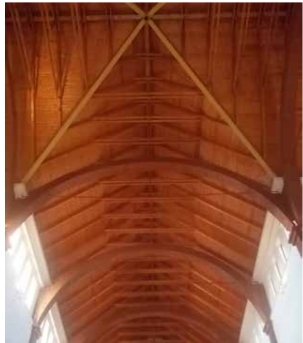
23. kép. A tiszaujvárosi római katolikus templom hajójának és keresztházának fedélszéke. (Fotó: Vámosi Katalin) Fig. 23. The nave and the roof construction of the transept of the Roman Catholic church in Tiszaujváros. (Photo by Katalin Vámosi)
