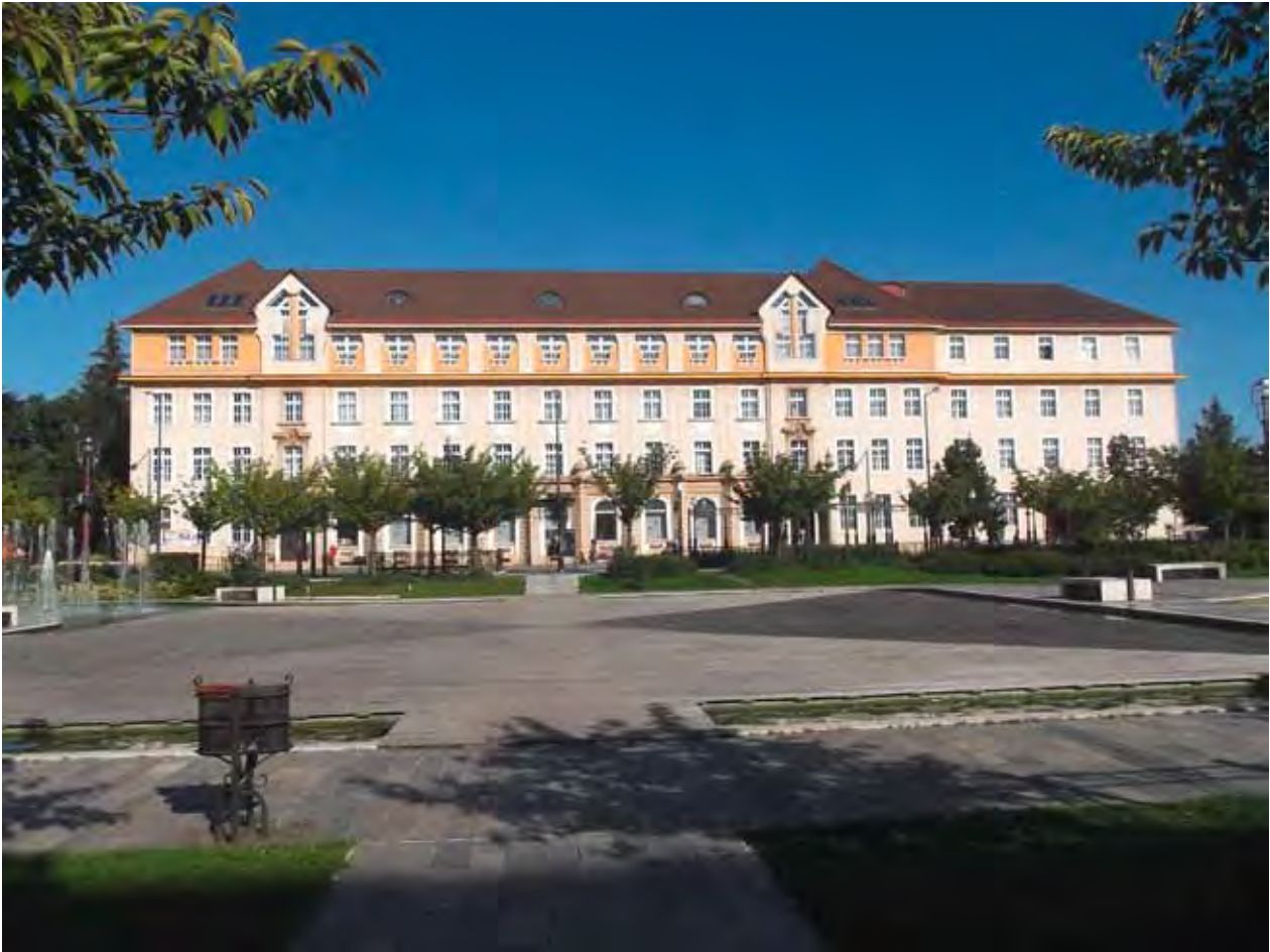
1. kép. A miskolci Postapalota 2016-ban. Az eredetileg szimmetrikus homlokzatú épületen jól látható a déli szárny bővítése (1950-es évek), és a későbbi emeletráépítés (1990-es évek). (A szerző fotója.)
