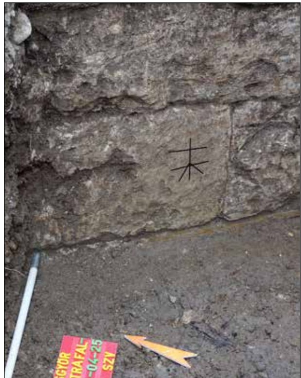
11. kép. Kőfaragó mesterjegye a diósgyőri vár kontrafalának belső oldalán (Fotó: Miskolczi Melinda) Fig. 11. Stonemason's master mark in the ashlar of the counterscarp (Photo by Melinda Miskolczi)
